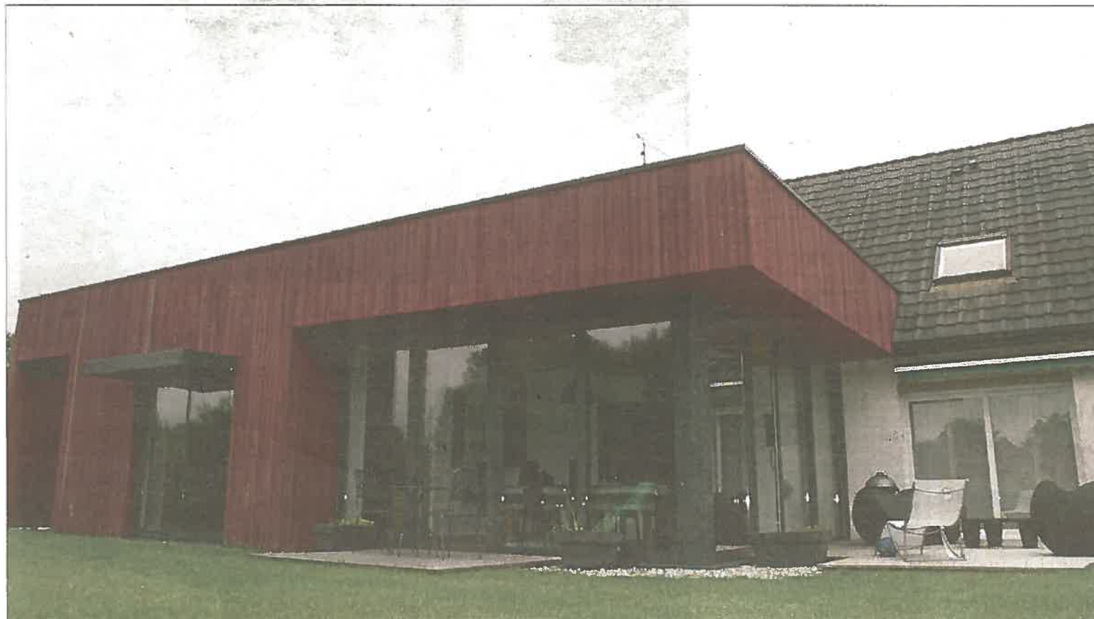
Ici, le séjour façon solarium dont le confort d'été est préservé. PHOTO LA VOIX ANNONCES
